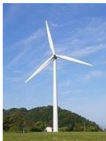
風力発電施設 3 号機
